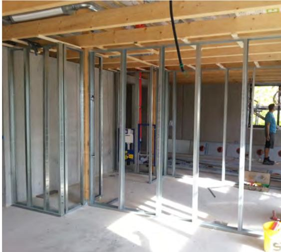
Beispiel Holzdachstuhl und Trockenbauwände
